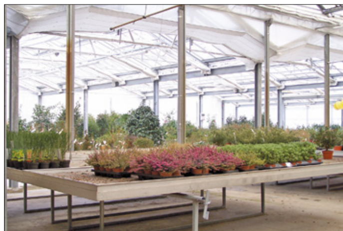
Sopra: due vedute parziali della nuova serra in ferro-vetro con bancali mobili ed irrigazione a terra con sistema flusso-riflusso.
